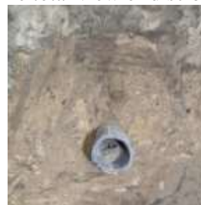
Рис. 6. Панорама исследований качества укладки труб
