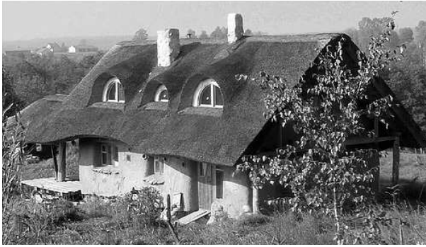
Rys. 1. Przykład domu z gliny (Fot. Waldemar Jan) Fig. 1. The house made of clay (Fig. Waldemar Jan)
