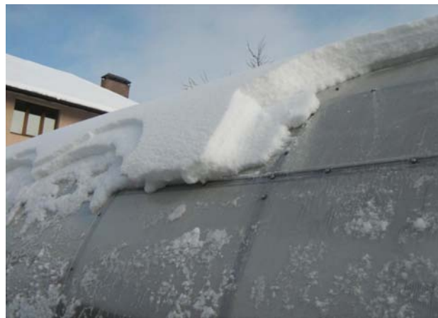
Рис. 2. Скопление снега на арочной поликарбонатной теплице
