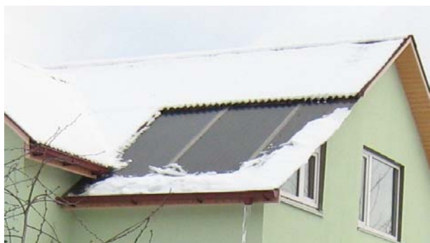
Рис. 3. «Зимний сад» внешний вид. Съемка с юго-западной стороны 20.02.2014 г.
